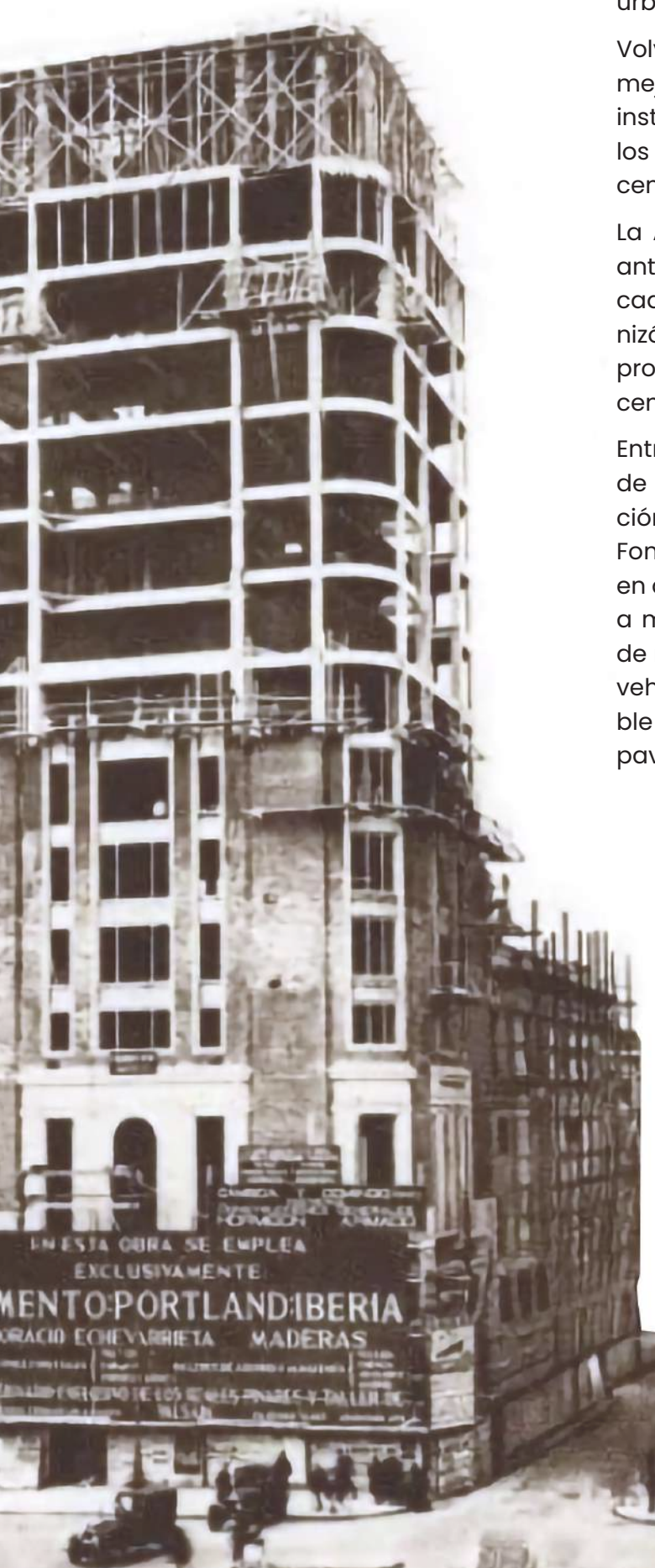
> Construcción de la Casa de la Prensa (Madrid)
